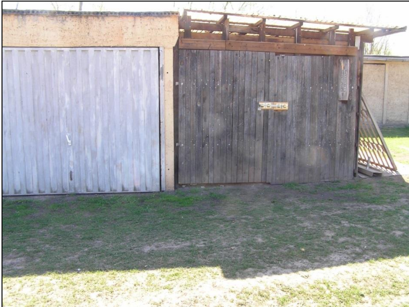
Abbildung 15: Kalträume Jenzigweg, Geräteschuppen
